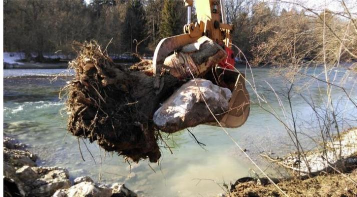
Wurzelstock mit Blockstein als Verankerung (Foto: Kästli Bau AG)
