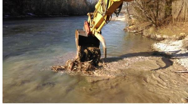
Abbildung 12: Überdecken des Blocksteins mit Flussskies (Foto: Kästli Bau AG)
