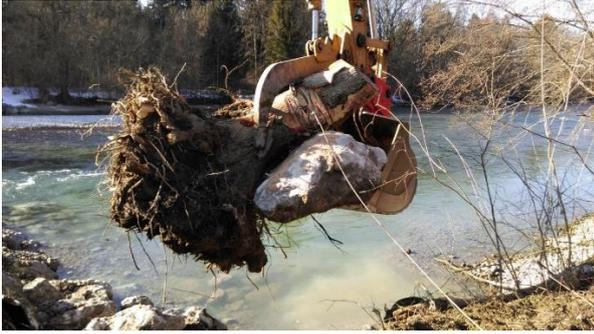
Abbildung 11: Fertig vorbereiteter Wurzelstock kurz vor dem Eintauchen ins Wasser (Foto: Kästli Bau AG)
