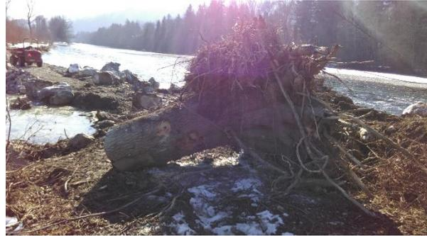
Abbildung 6: Vorbereiteter Wurzelstock mit Loch für das Drahtseil (Foto: Kästli Bau AG)
