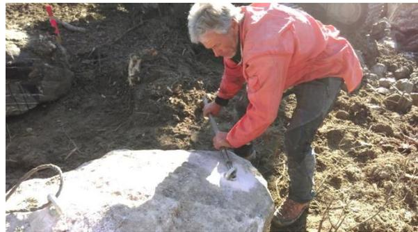
Abbildung 8: Einsetzen des Felsankers, anbringen und vorspannen der Ringmutter (Foto: Kästli Bau AG)
