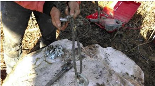
Abbildung 9: Befestigen des Drahtseils an der Ringmutter (Foto: Kästli Bau AG)
