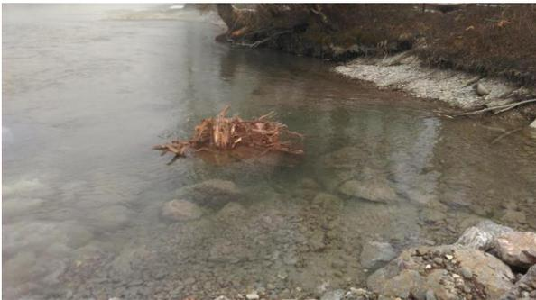
Abbildung 13: Wurzelstock einen Tag nach der Erstellung mit Blick in Fließrichtung abwärts (Foto: Kästli Bau AG)
