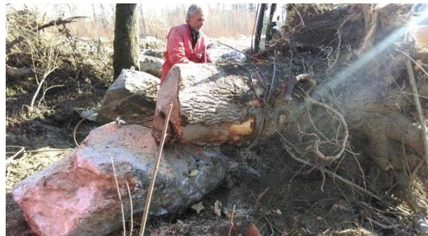
Abbildung 10: Durch- und Umschlaufen des Wurzelstocks mit dem Stahlseil (Foto: Kästli Bau AG)
