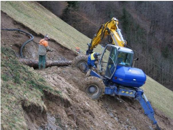
Abbildung 4: Verbau der Anrissfläche mit verankerten Schwellen
