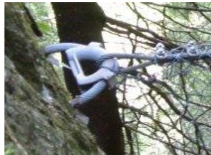
Der U-Anker ist ein umgelenkter, in zwei separaten Löchern vermörtelter Seilanker. Zum Schutz der Umlenkung wird die angehängte Last über eine Kausche übertragen.
