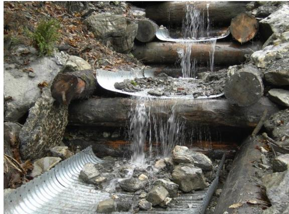
Wellstahlbleche als Erosionsschutz (Quelle: bap Ingenieurbüro, Summaprada)
